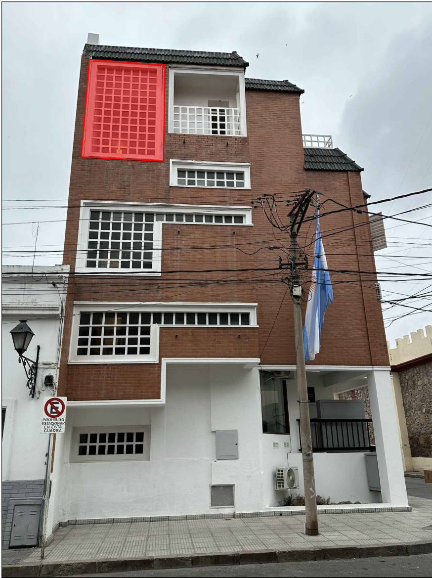
Ventana a impermeabilizar
