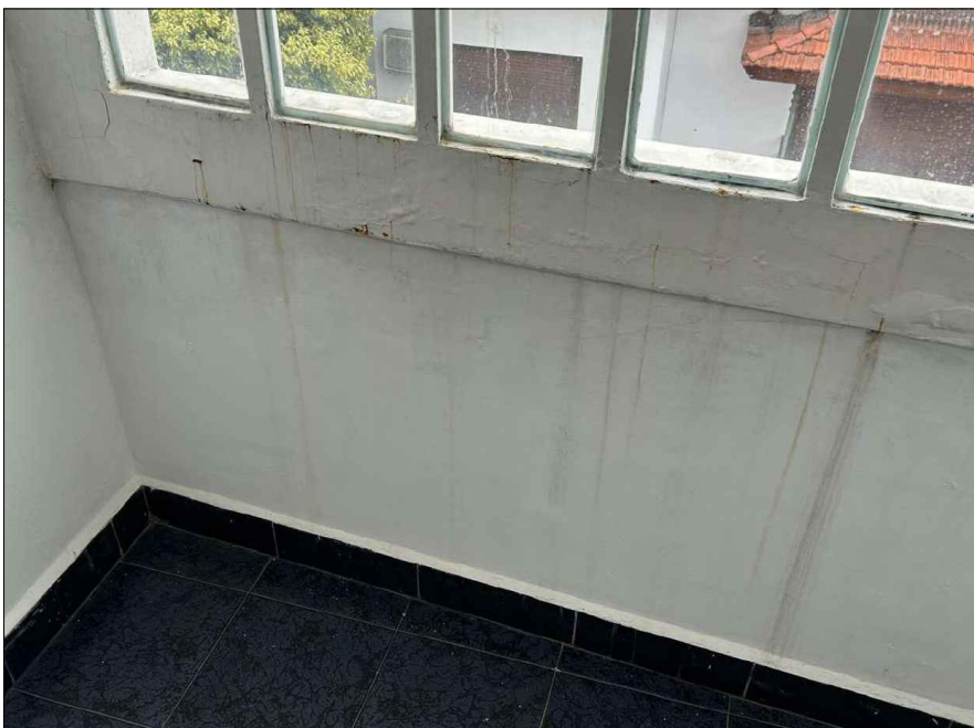
Interior de ventana a reparar
